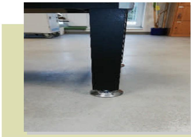
Geschafft! Das Gewinde ist fertig und der Fuß montiert.
